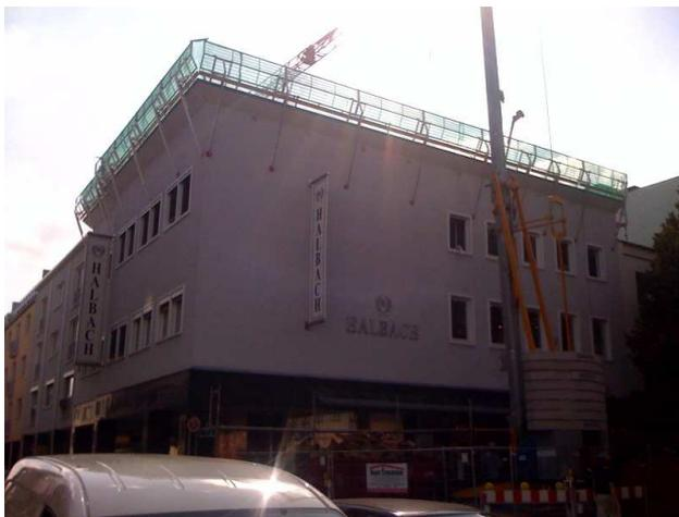
**Bei diesem Kaufhaus hätte ein konventionelles Standgerüst im Bodenbereich störend gewirkt. Mit Hilfe des RSS – Steildachsystems ( SD ) konnten die Arbeiten im EG ungehindert weiter geführt werden und die Dacharbeiten waren dennoch professionell gesichert. Fassadenarbeiten waren bei diesem BV nicht geplant. Eine optimale Lösung für diese Baustelle.**
